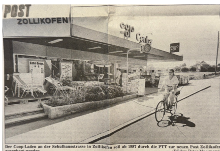
Der Coop-Laden an der Schulhausstrasse in Zollikofen soll ab 1987 durch die PTT zur neuen Post Zollikofen umgebaut werden. (Bild: Peter Mosmann)
