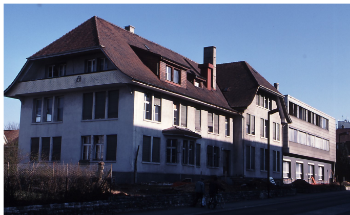
Die leer stehende Textilfabrik Knechtli an der Bernstrasse (Bild: 2000).
